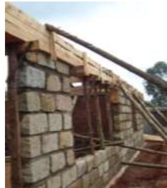
وينهى (9-11) ا- سهر په نجهرى كونكريتي شيشچن له جيدا داږيژراو ب- سهر په نجهرى كونكريتي شيشچن پيشكات نيمچه ناماده كراو
