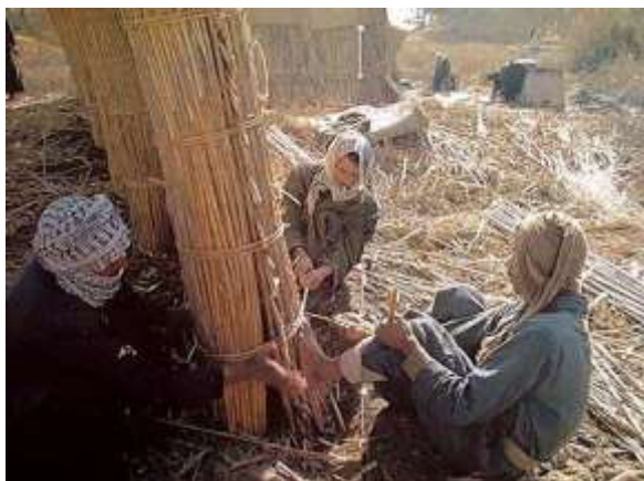
وئىنەي (7) شىۋازى دروستكردنى خانوو ئە زەل و قامىش ئە باشوورى عىراق
