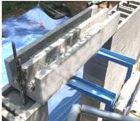
وينهى (9-11) ا- سهر په نجهرى كونكريتي شيشچن له جيدا داږيژراو ب- سهر په نجهرى كونكريتي شيشچن پيشكات نيمچه ناماده كراو
