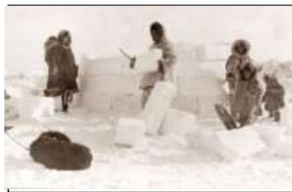
وئىنەى (4) شىۋازى دروستکردنى بىناى كلۇى بەفرىن (ئىگلۇ) ئە لای ئەسكىمۇكانى ئالاسكا
